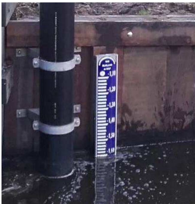
Voorbeeld van een peilschaal met verticale houten gording die is uitgevuld, zodat peilschaalhouder van bovenaf over de muurplaat kan worden geschoven
